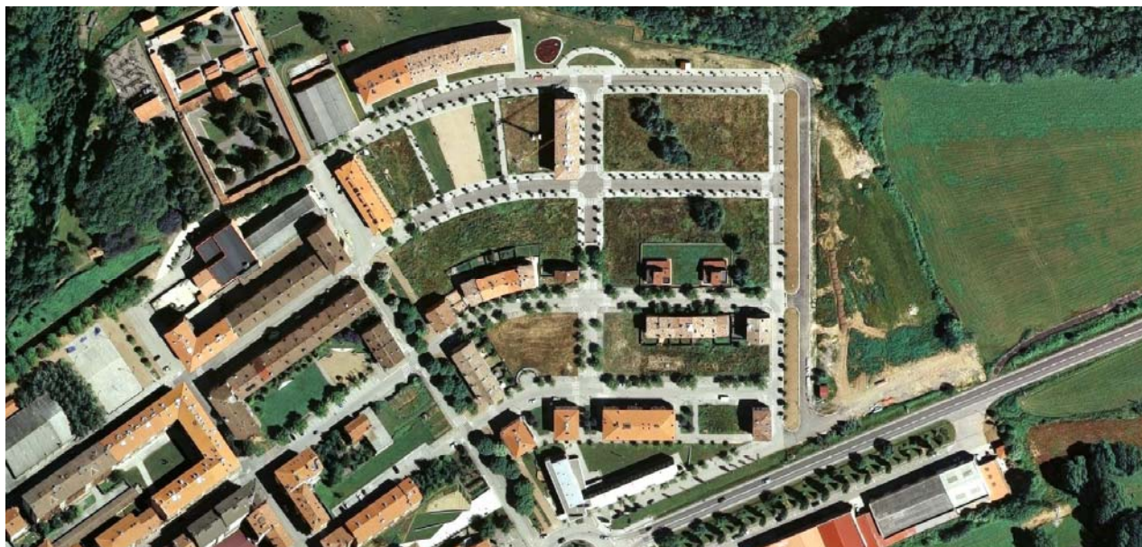
VISTA GENERAL DE L'ÀMBIT
